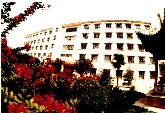
县医院住院楼
