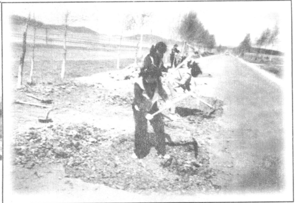
大桥道班工人维修油路
