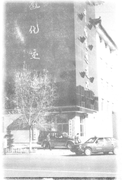
敦化市交通运输管理所办公楼
