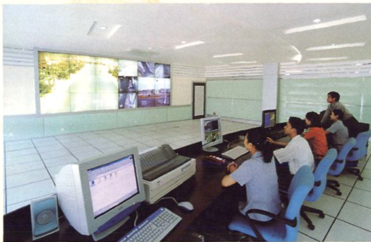
常德卷烟厂监控室
