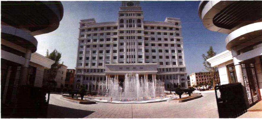
现办公大楼全貌
