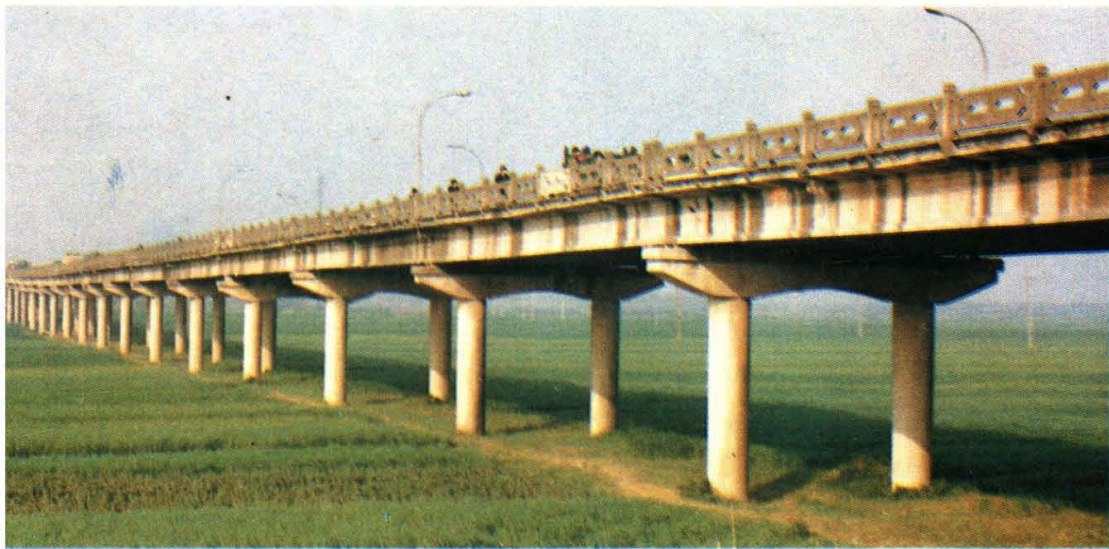
全区最长的公路桥——潜江东荆河大桥
