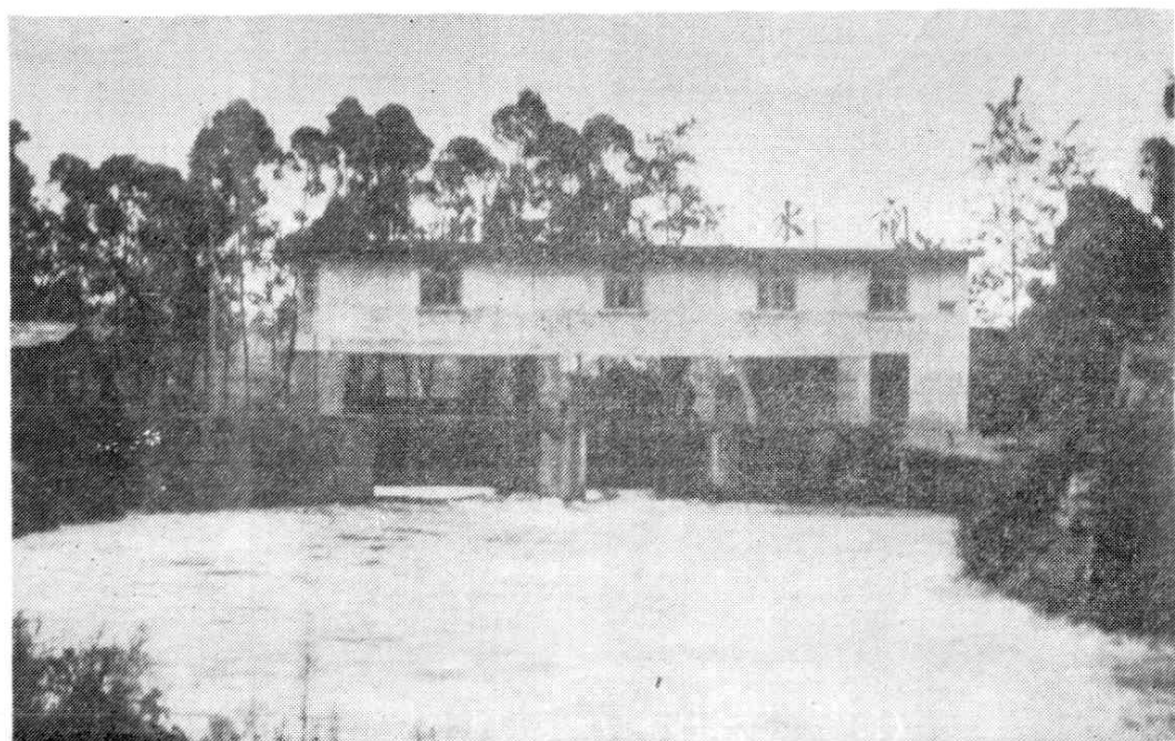
东风渠（麻石桥分水闸）
