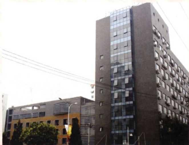
▲ 建设中的教师大厦新楼外景（原北京实验大学校址，现为学院中轴路校区）
