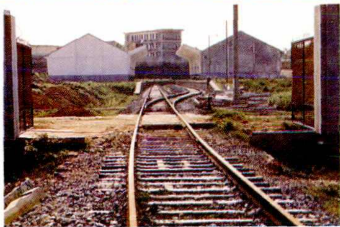
▶ 长桥粮库铁路支线
