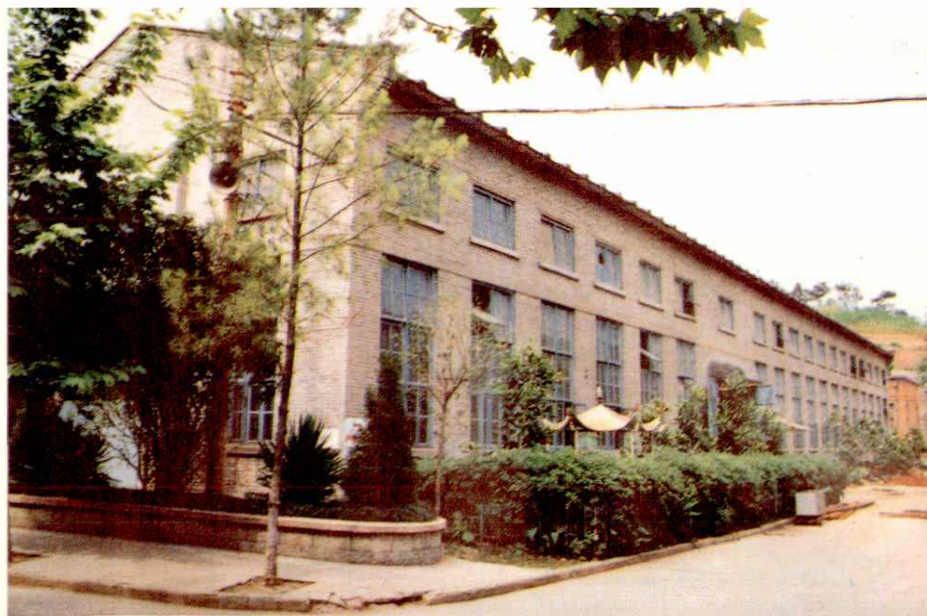
扩建后的机修车间
