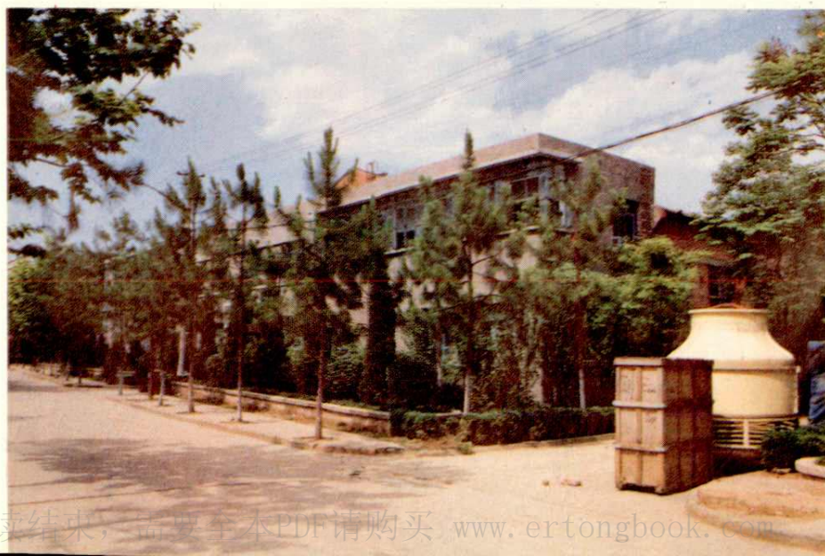
改造后的冲压车间
