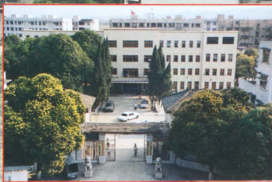
县人民政府办公大楼 (1998年摄)
