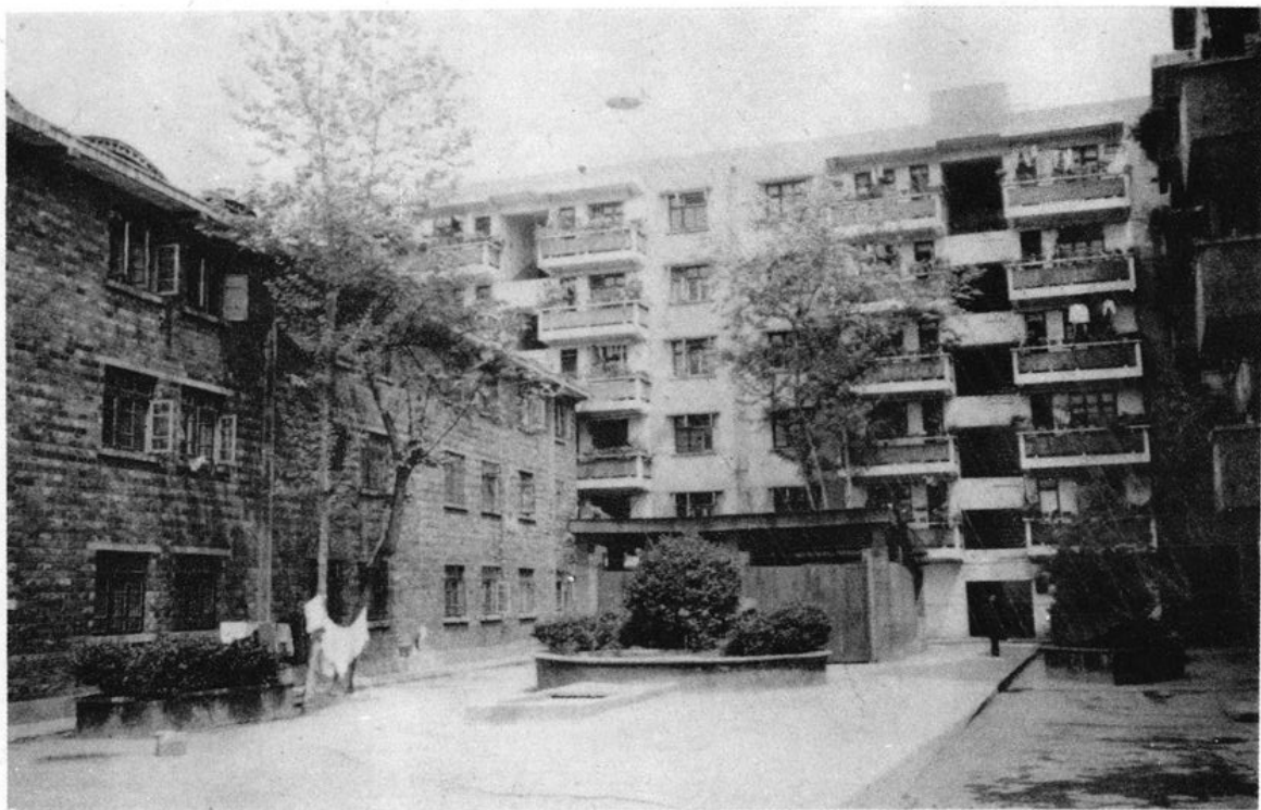
绵阳市市中区农业局职工宿舍楼
