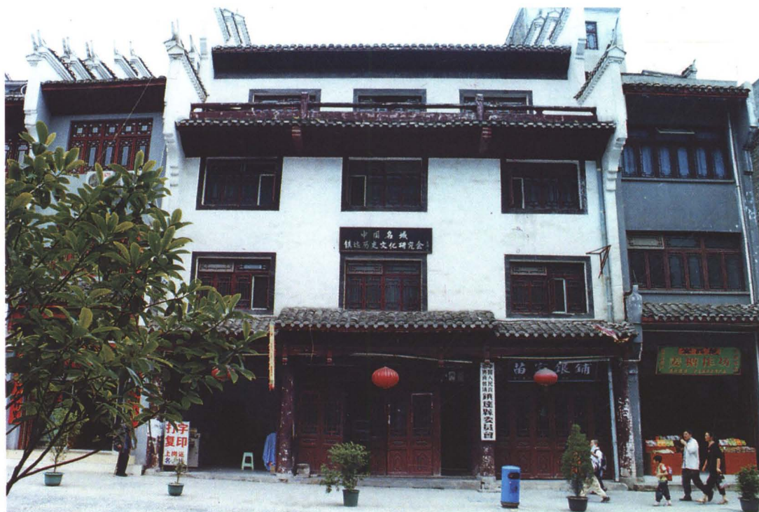
镇远县政协办公楼（建於1987年）
