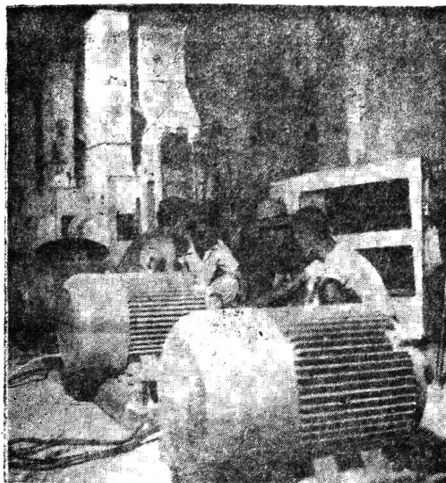
← 第二制米厂正在安装现代化碾米机设备
