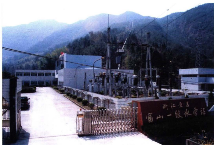
富山一级水电站
