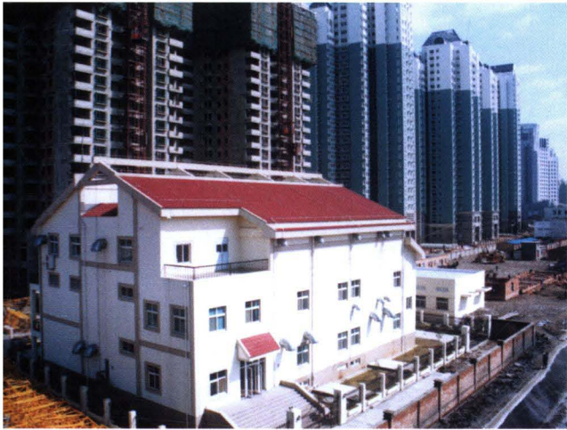
110 千伏滨江变电所
