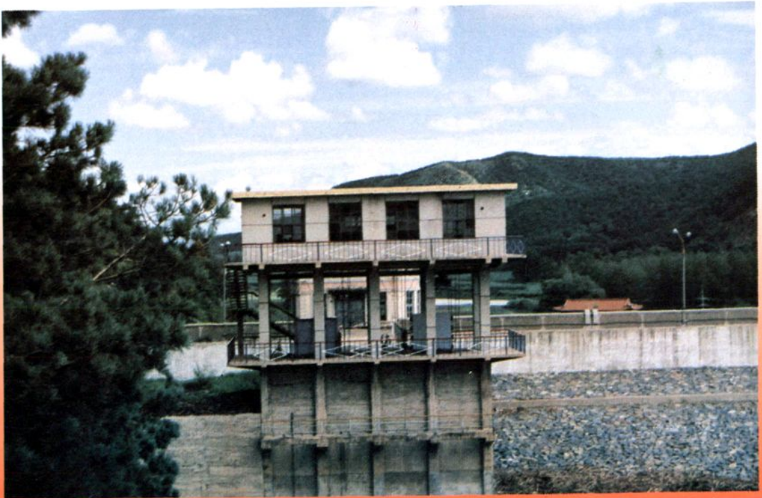
输水洞进水闸
