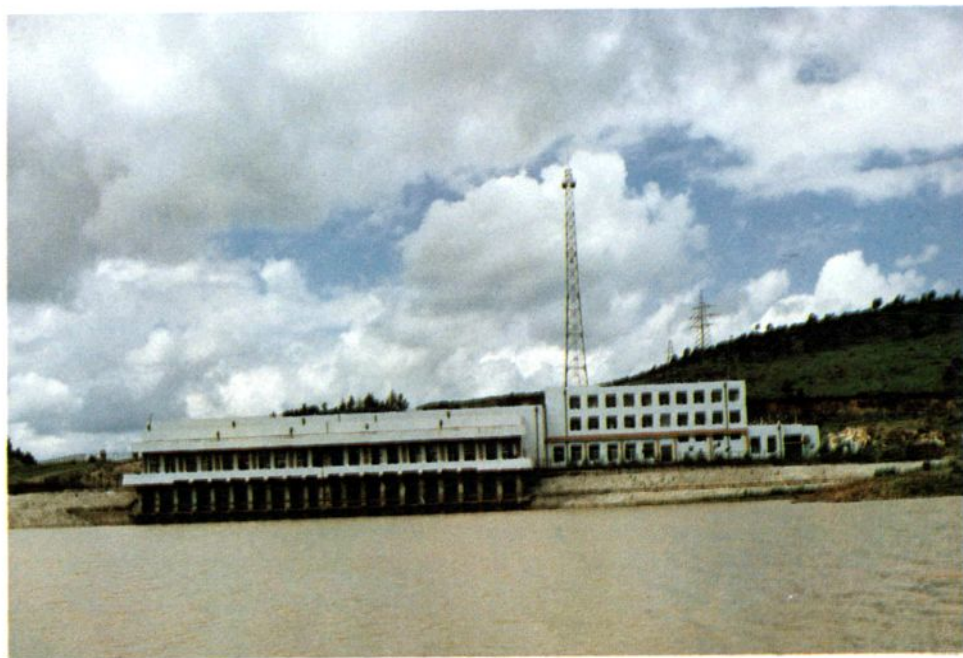
“引松入长”工程石头口门水库泵站
