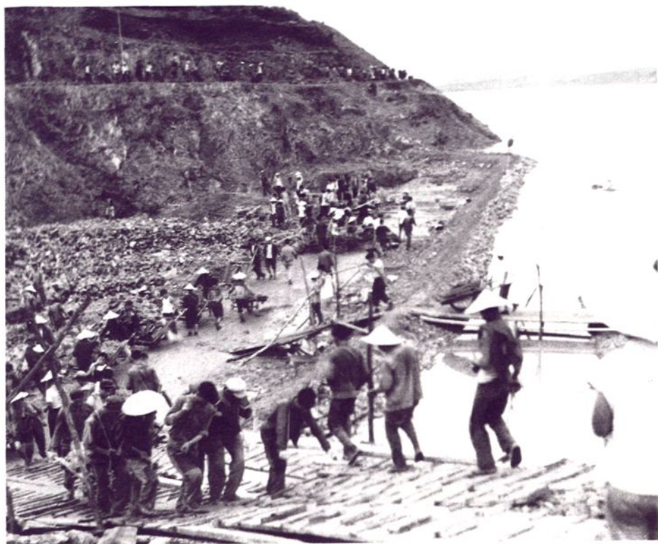
1958年兴建石头口门水库开挖溢洪道施工时的情景
