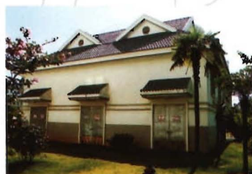
居民小区低压配电室
