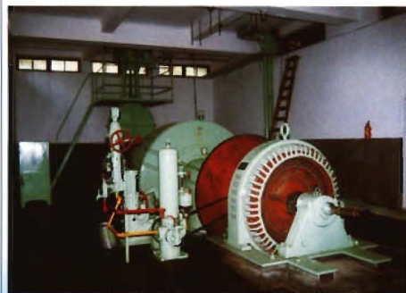
湖海塘水力发电站200千瓦水轮发电机组
