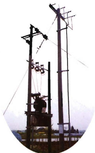
农村配电变压器台区
