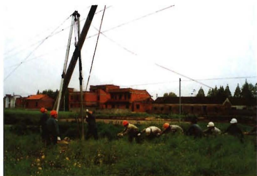
10 千伏线路施工现场
