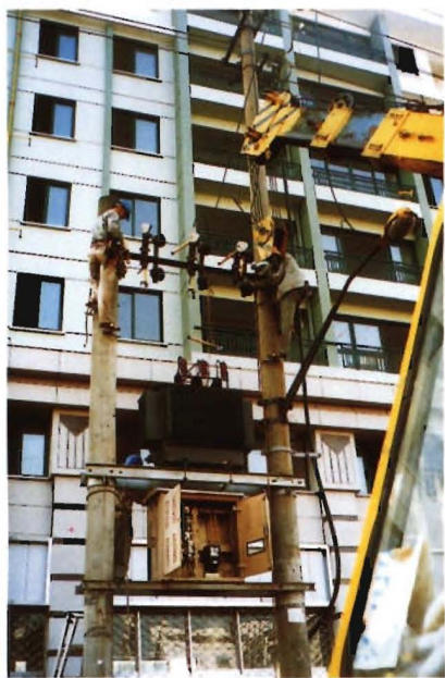
市区配电网改造现场
