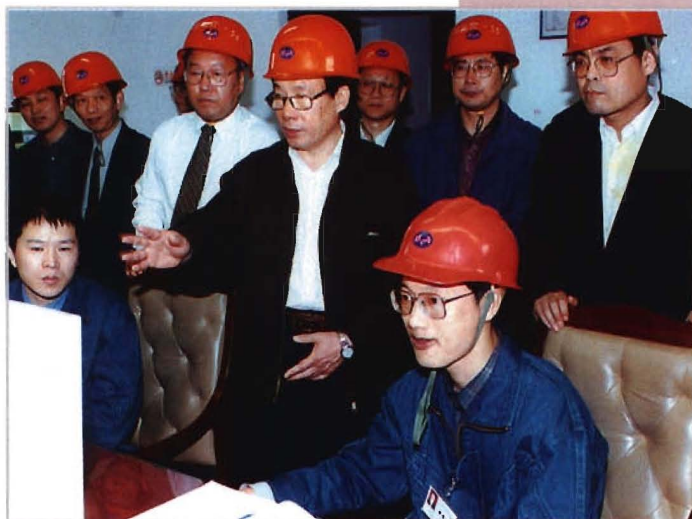
1999年4月9日，国家电力公司副总经理陆延昌（中）由浙江省电力公司总经理陈积民（后左三）等陪同视察500千伏金华双龙变电所
