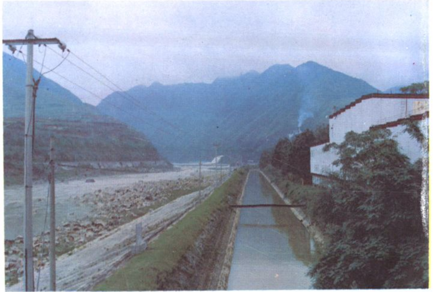
褒惠渠渠首段
