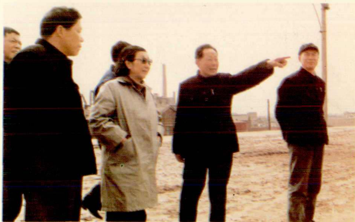
1986年3月18日，水电部部长钱正英在王汉章、曾凡荣等陪同下，视察监利荆江大堤加固工程。贺道富摄
