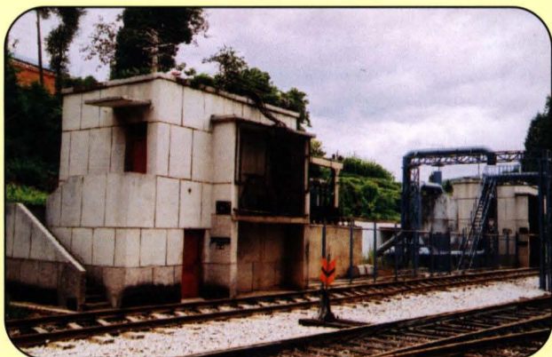
▲ 内燃机车水阻试验台
