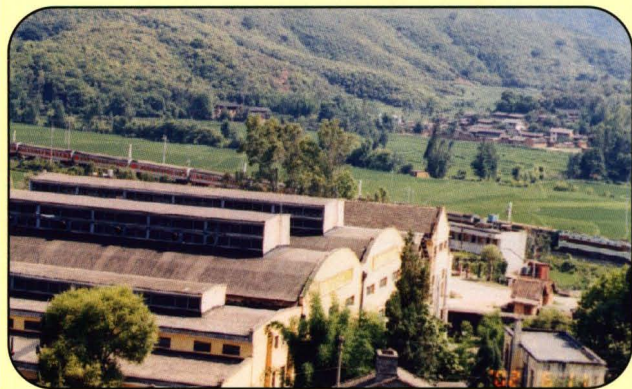
▲ 检修车间面貌
