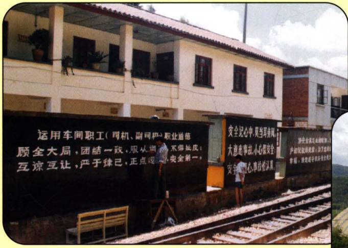
▲ 原运用车间办公楼
