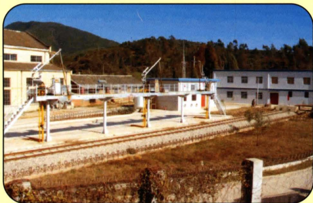
▲ 接卸燃油工作台
