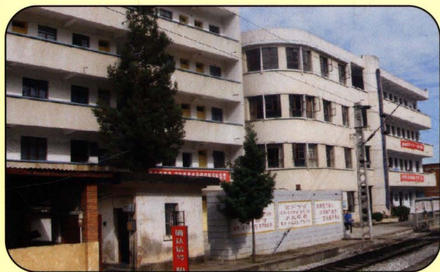
▲ 地检、运用办公大楼
