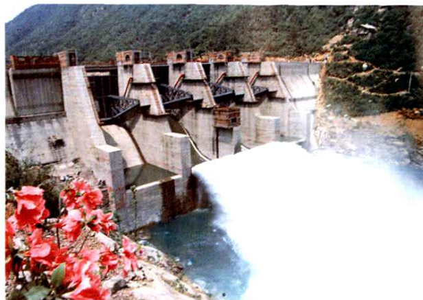
青山殿水电站
