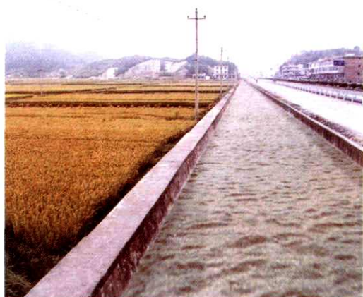
青山水库南干渠
