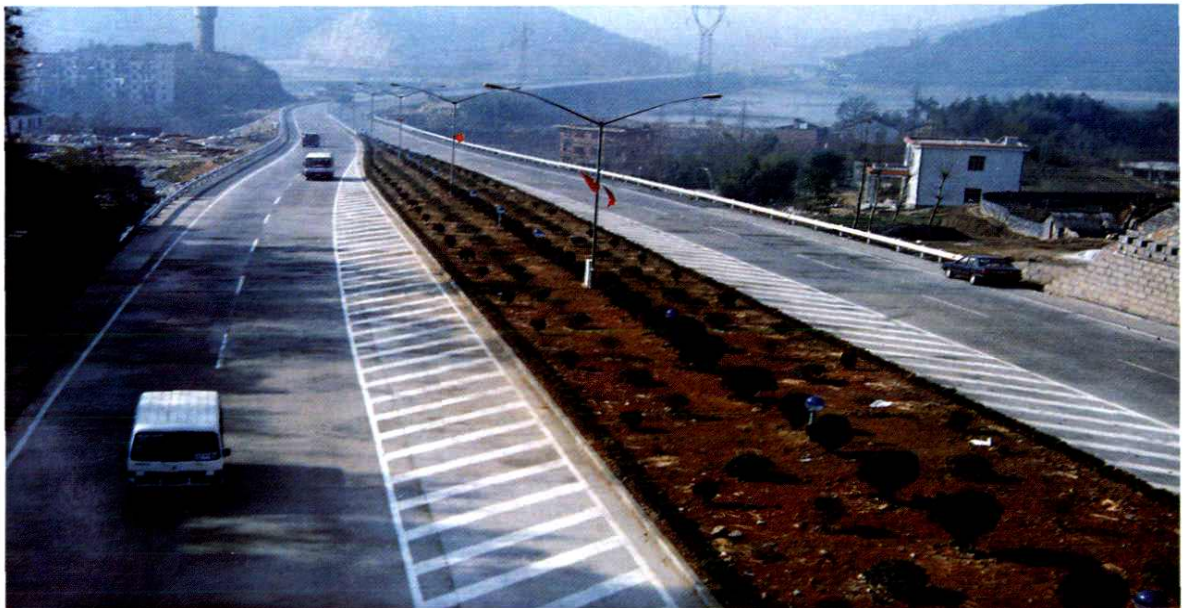
省道——杭昱线临安段一级公路
