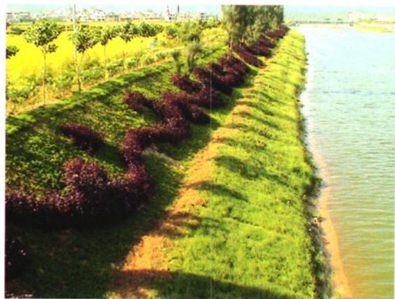
建设生态护岸工程
