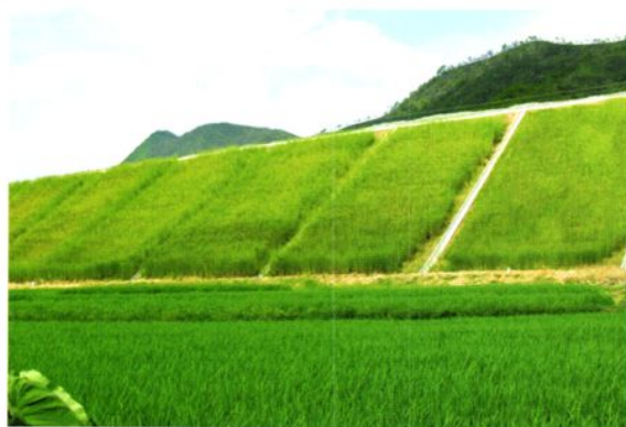
公路边坡植物措施防治水土流失
