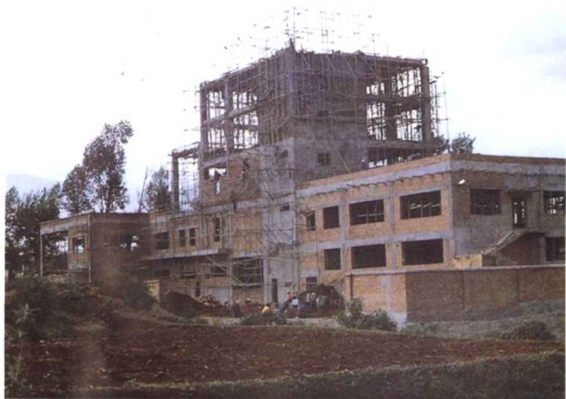
荷兰引进项目新的奶粉车间正在施工
