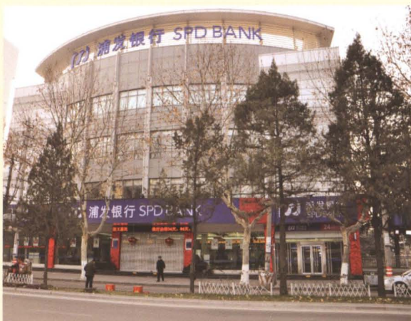
上海浦东发展银行股份有限公司淮安分行办公楼（淮 安市淮海西路83号）
