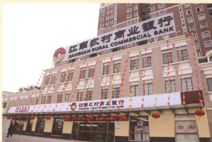
江南农村商业银行涟水县支行办公楼（江苏省涟水县红日西大道7号）
