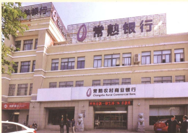
江苏常熟农村商业银行金湖县支行办公楼（江苏省金湖县黎城镇衡阳路228号）
