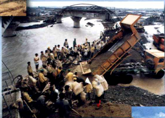
▶1996年7月20日,兰新线柴西~煤窑沟间,白杨河大桥抗洪现场。
