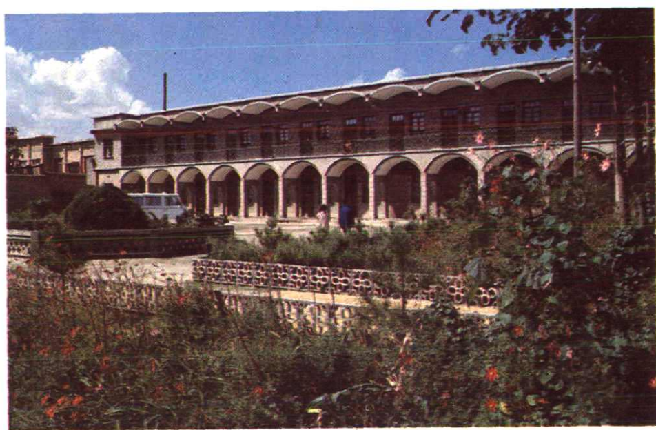
新建的常宁人民公社办公楼
