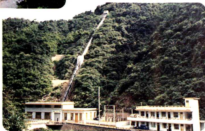
张溪二级水电站全貌
