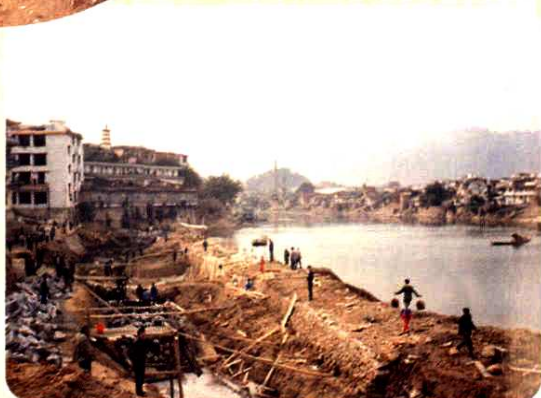
城市防洪排涝工程施工
