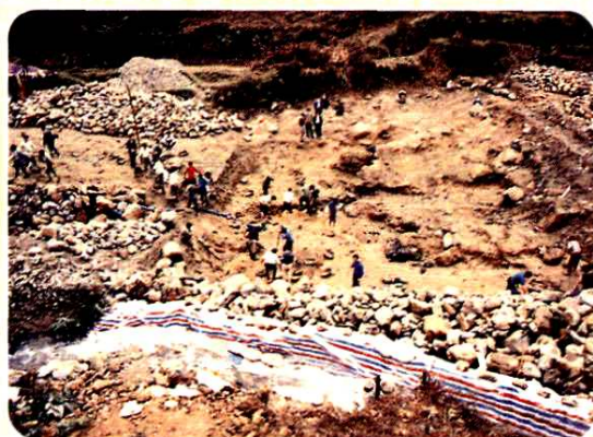
九峰水泥石流防治工程 坝址清基
