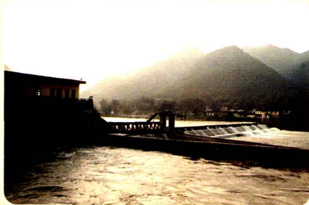
张滩水电站大坝原貌
