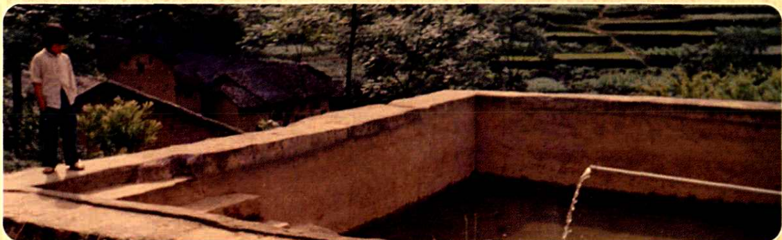
沙坪镇茫洞村老屋水池
