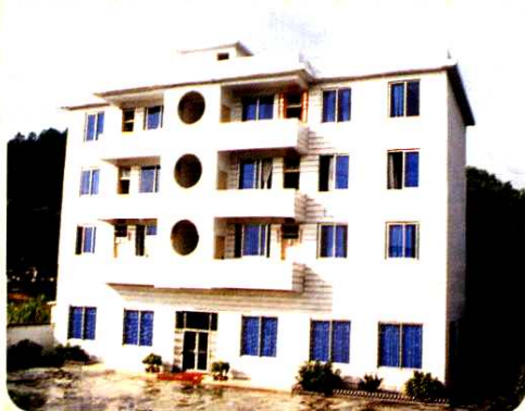
廊北水利管理处综合大楼
