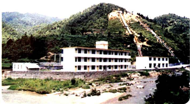
王龙二级水电站全貌
