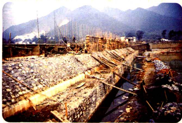
张滩水电站大坝加高工程
