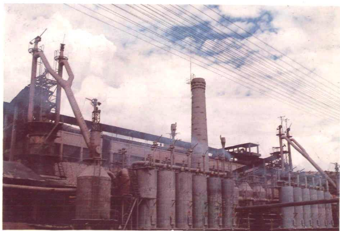
峨山钢铁厂37立方米高炉
