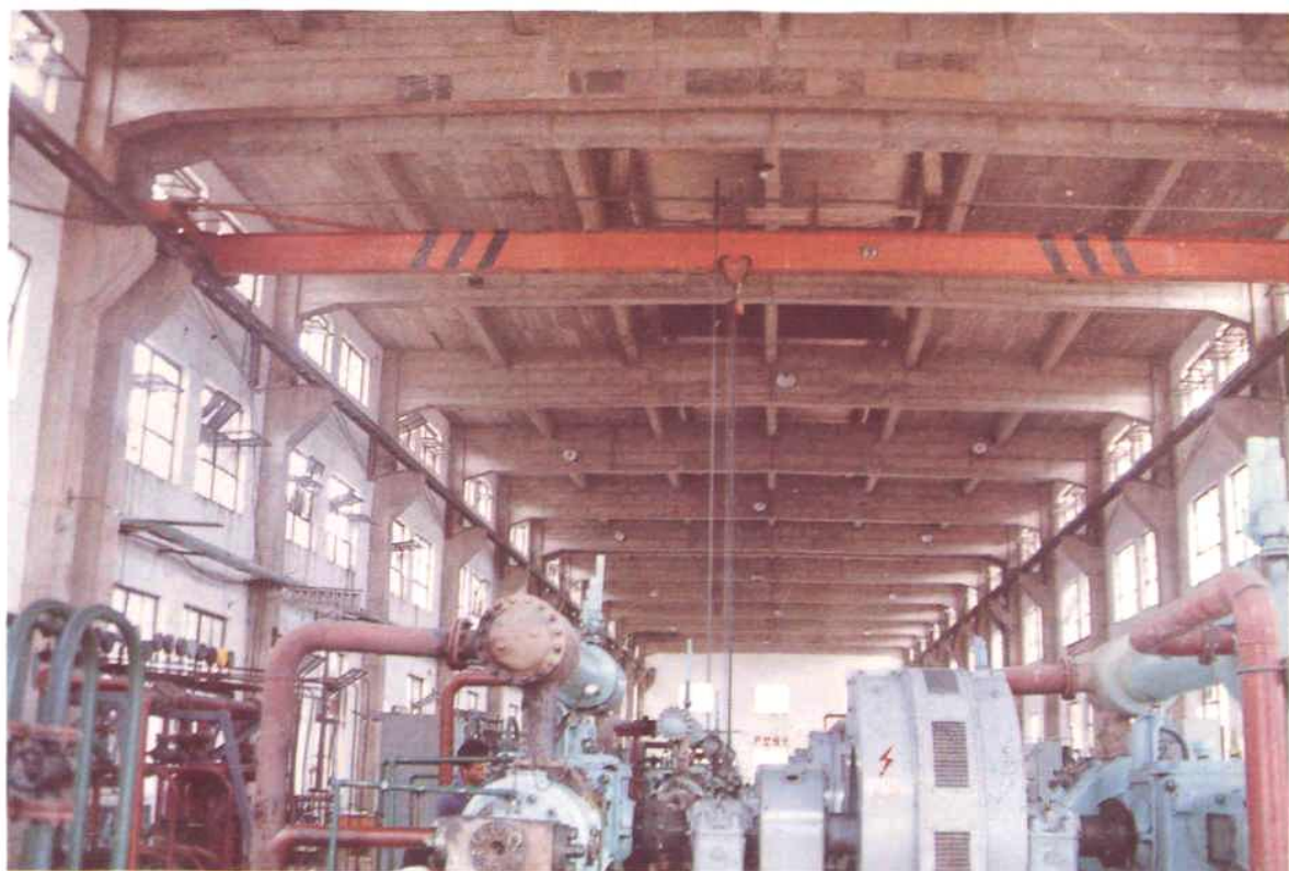
旬中镇建筑公司承建的县氮肥厂联合厂房
