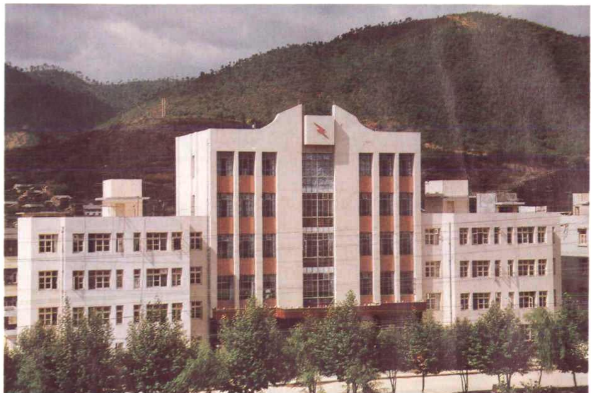
双江建筑公司承建的县电力公司综合楼
