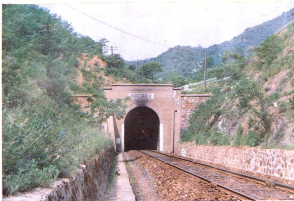
礼垣铁路支线“西沟二号隧道”
