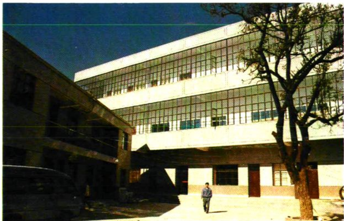
高峯程控电话大楼
