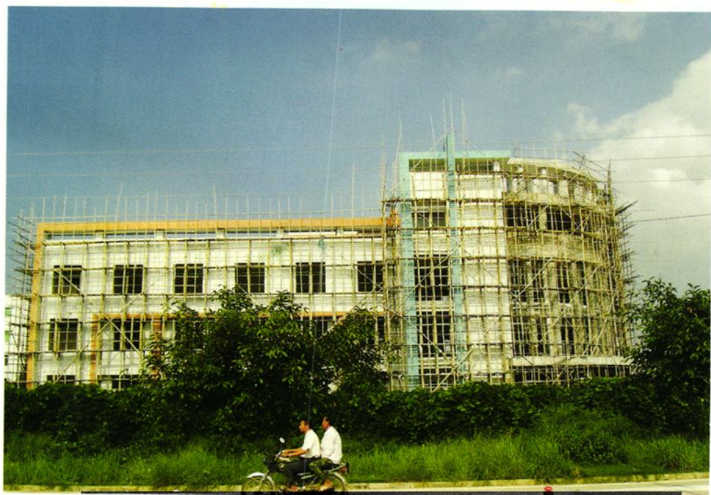
▲ 正在兴建的中国南方汶村供电所大楼
