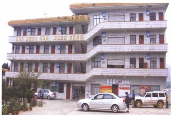
罗雄镇第一中学办公楼(1997年建成)
