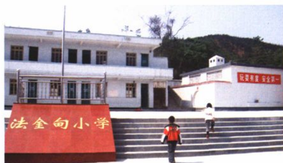
法金甸小学教学楼（1994年建成）
