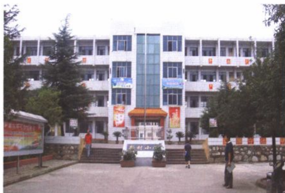
新村小学教学楼(1997年建成)
