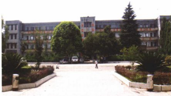
蜡峰小学教学楼（1985年建成）
