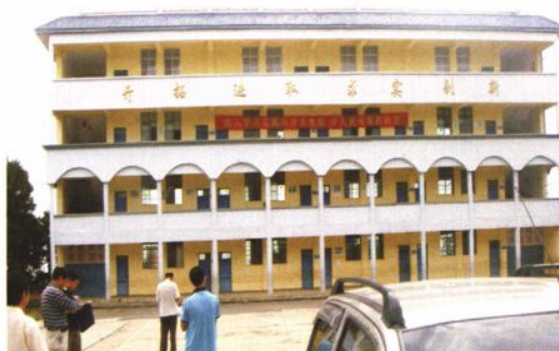
大水塘小学教学楼（2005年建成）
