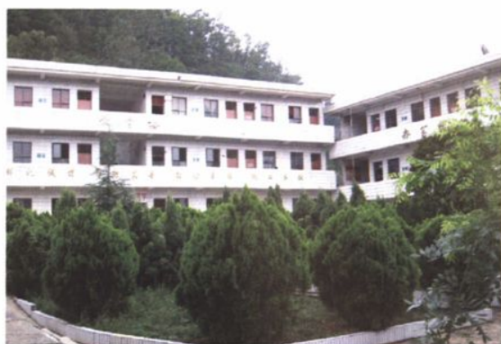
幸多禄小学校园(1996年建成)
