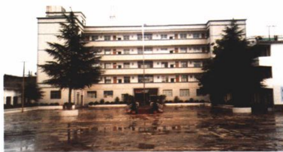
东屏小学教学楼（1991年建成）
