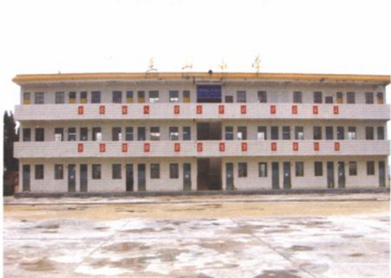
圭山小学教学楼(1999年建成)
