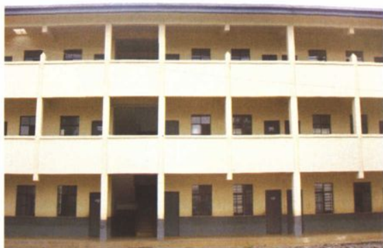
新寨小学教学楼（2008年建成）
