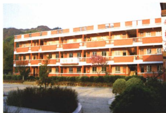
羊者窝明德小学教学楼（2007年建成）
