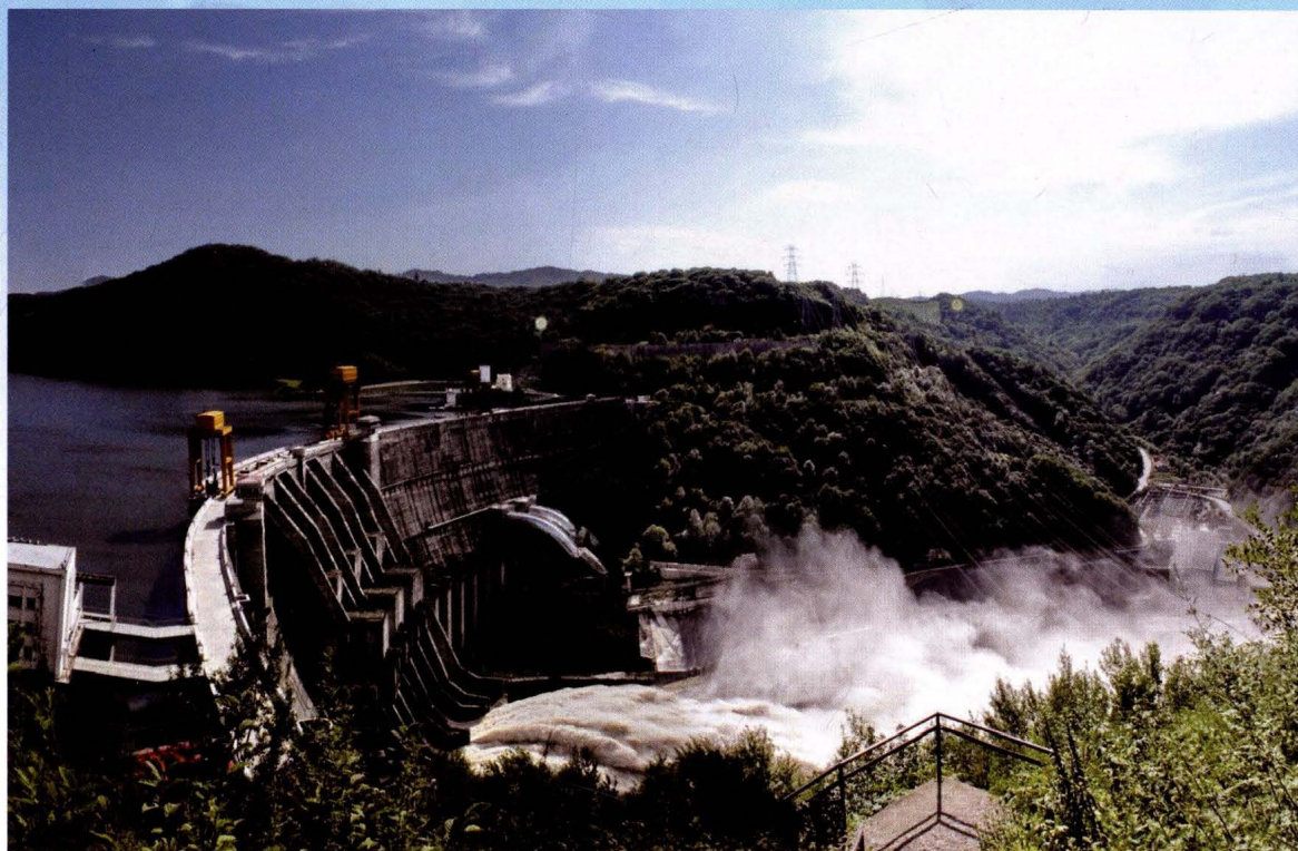
白山发电厂大坝泻洪
