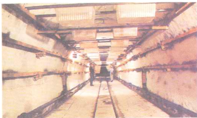
△ 中国煤炭科学院重庆分院 1983 年完成瓦斯煤尘爆炸试验巷道及其测试系统的研究。
