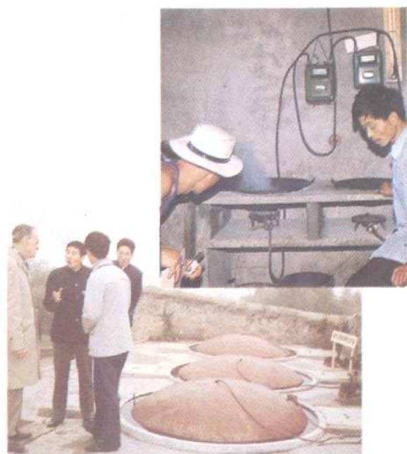
△ 1981 年重庆市沼气科研站与塑料研究所合作研制成沼气池红泥塑料顶罩及灶具，右上图为炉灶，左下图为美国经济考察团人员到现场参观。
