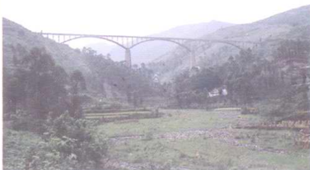
△ 江北县 1980 年 3 月建成胜天水库小桥渡槽。
