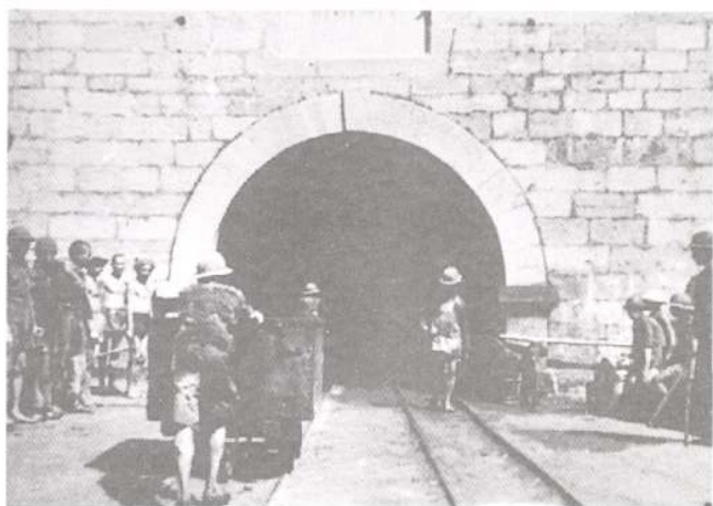
△ 40年代建成的天府煤矿矿井洞口。
