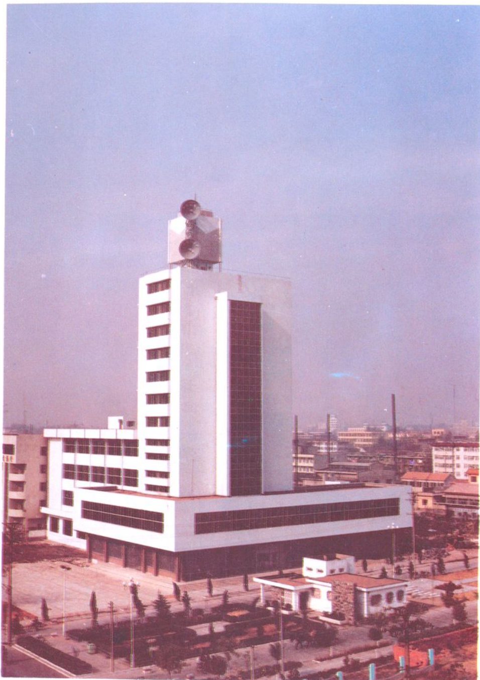
新落成的胶州邮电大楼位于湖州路与郑州东路交叉口处。该楼 11 层高 66.7 米,总建筑面积为 7038 平方米。
