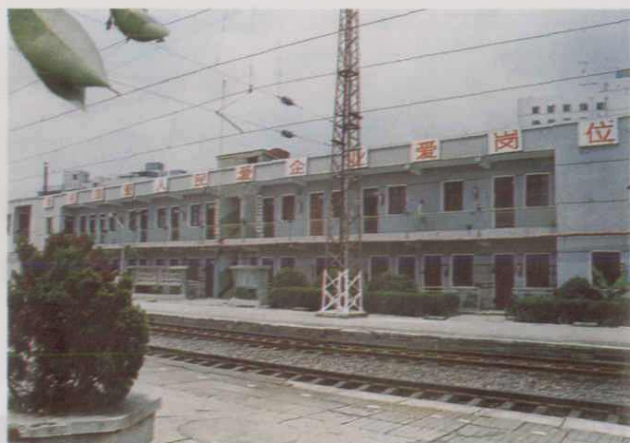
现江岸车站站址
