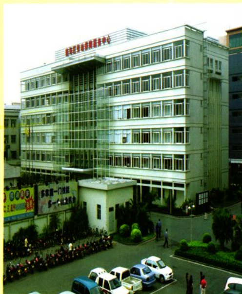
2002年建成的南海区劳动保障服务中心
