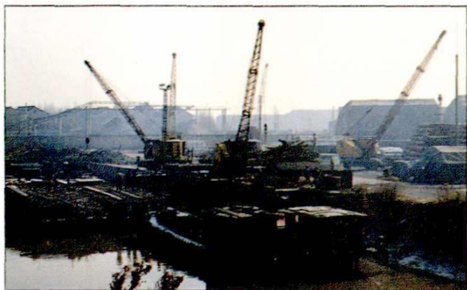
港口装卸储运公司春申塘堆栈码头
