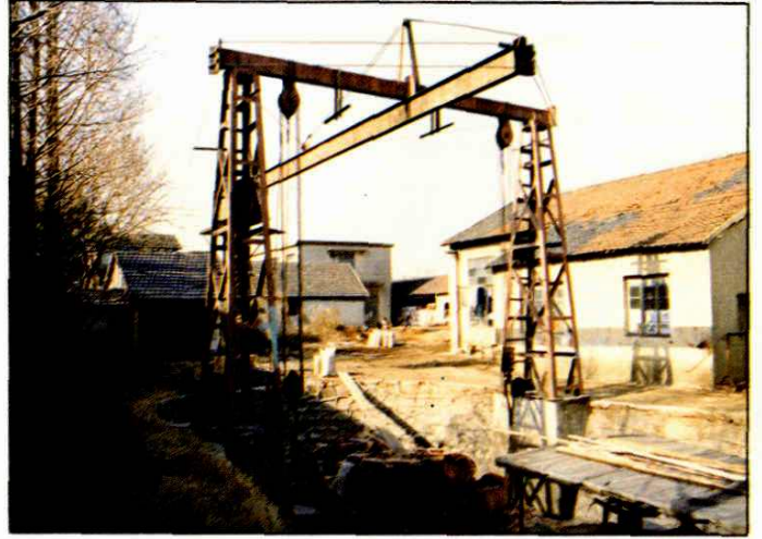
上海县内河运输公司船舶保养场修船设备
