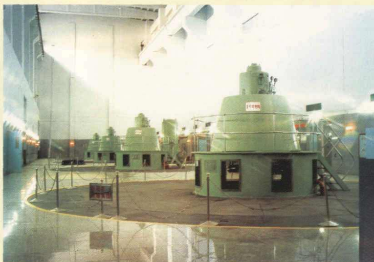
维修后的发电机层
