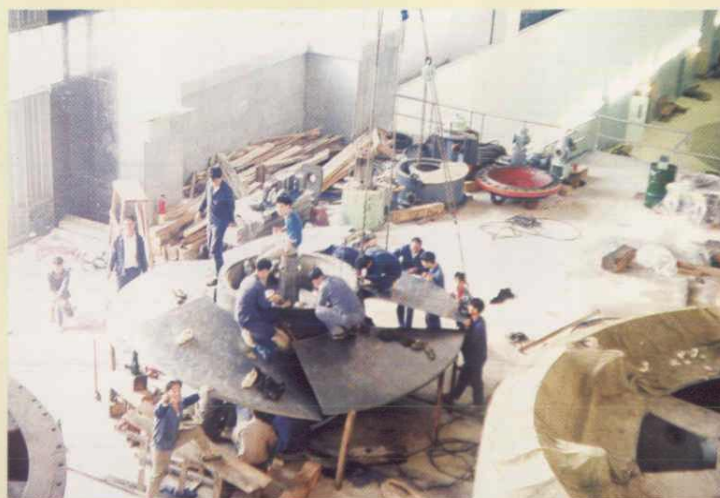
利用机组检修改造设备
