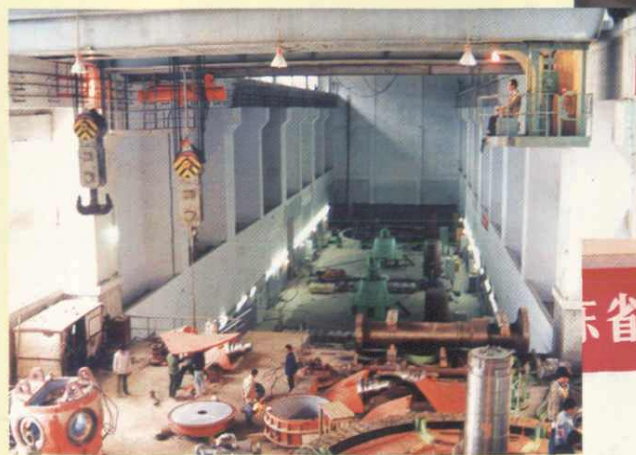
4号机组机电设备安装现场
