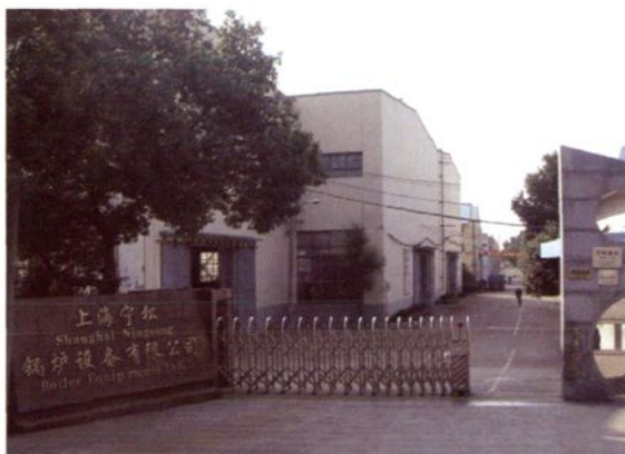
上海宁松锅炉设备有限公司
