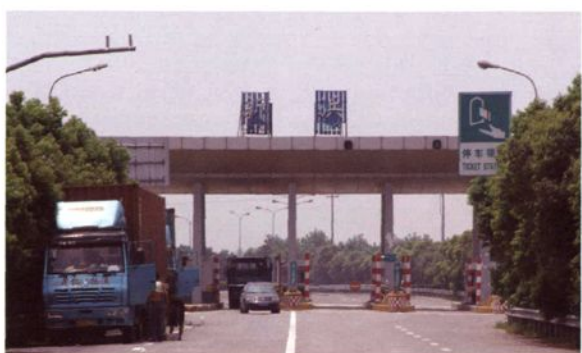
沪杭高速公路 (G60) 新浜出口
