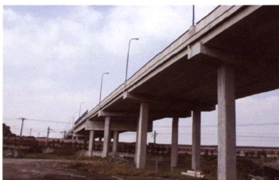
叶新公路沪杭铁路交汇处高架桥
