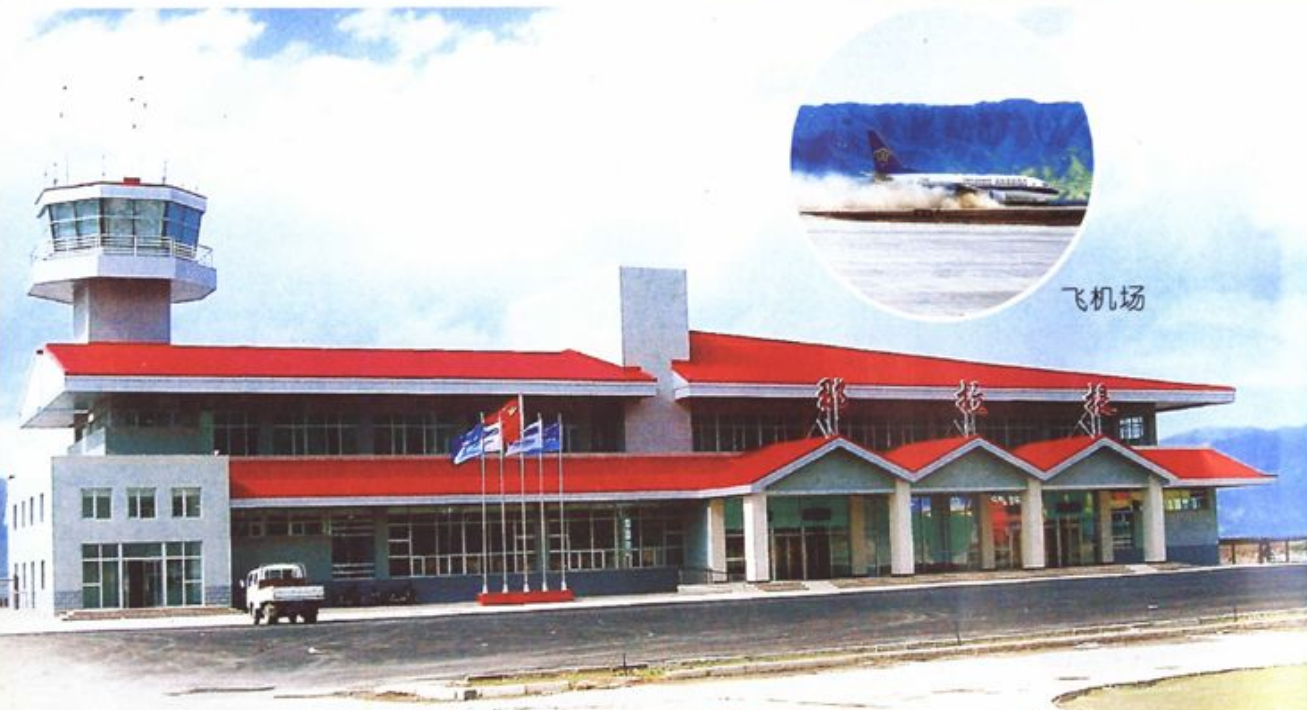
新疆那拉提飞机场候机楼（新源县阔尔墩）
