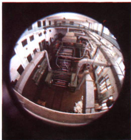
杭州塑料厂PVC无毒硬片 生产线
