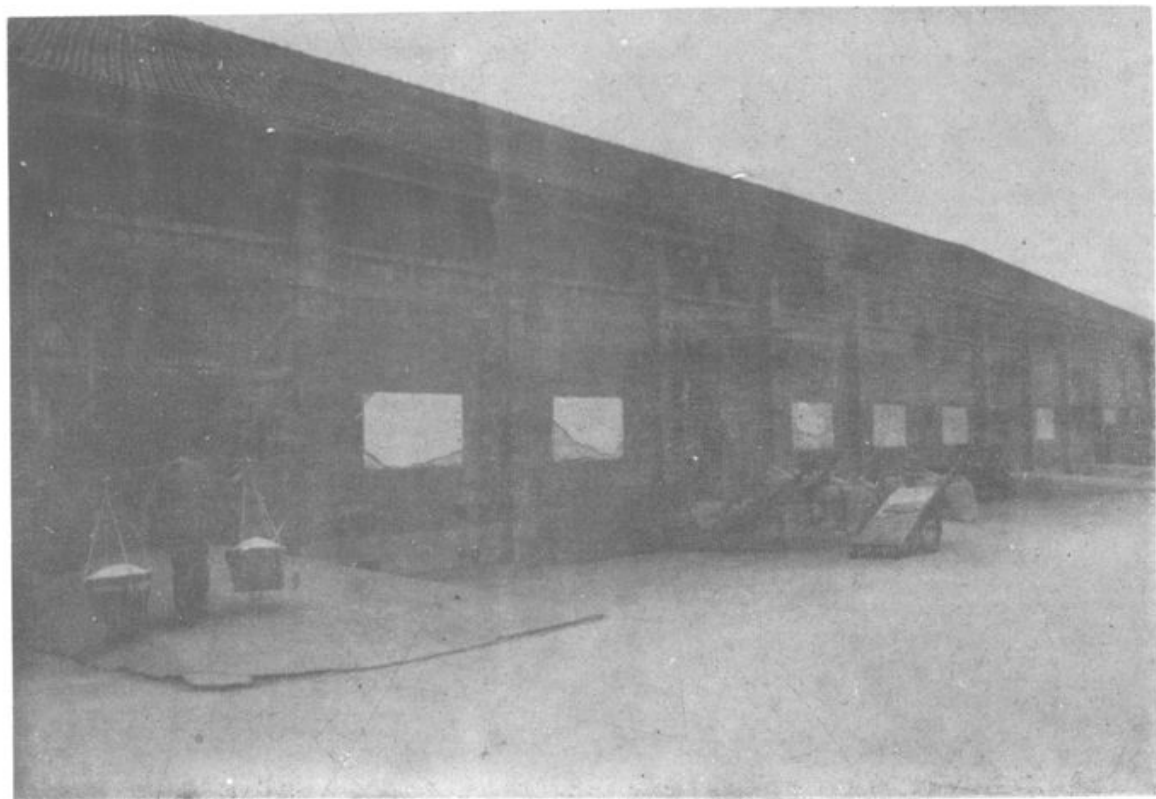
盐城市粮油供应公司向阳粮站英式仓，建于1951年。
