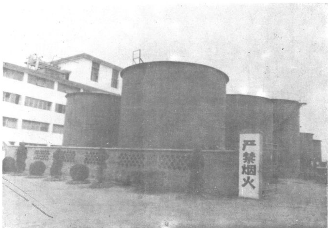
射阳油化厂一角。
