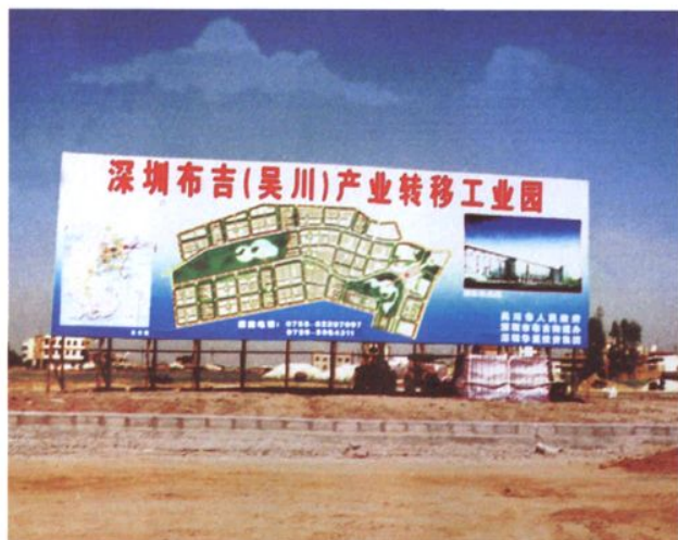
回归工程——深圳布吉（吴川）产业转移施工工地
