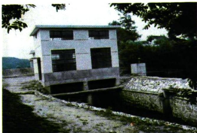
双港镇清河电力排灌站
