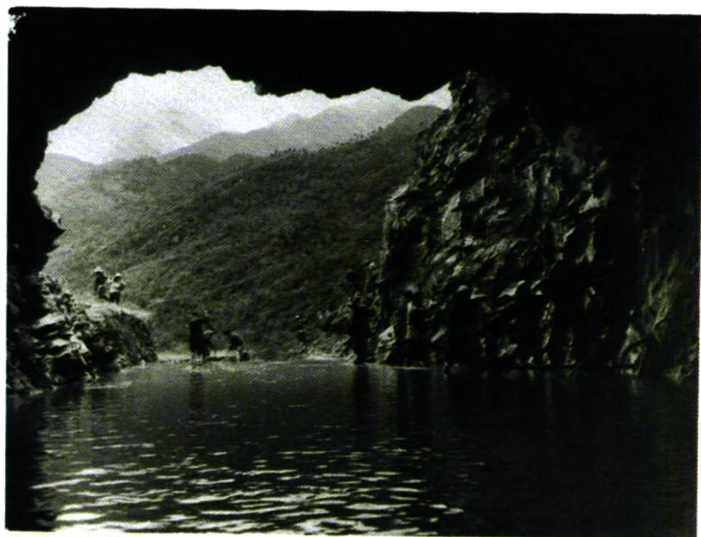
唐湾镇红旗洞施工场景
