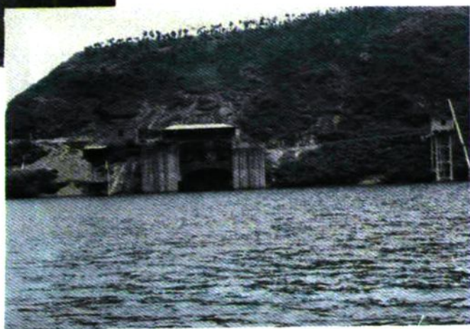
牯牛背水库灌溉、泄洪、 发电三隧洞进口设施
