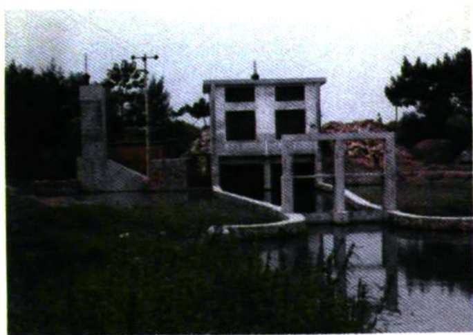
孔城镇姜团圩东斗门电力排灌站
