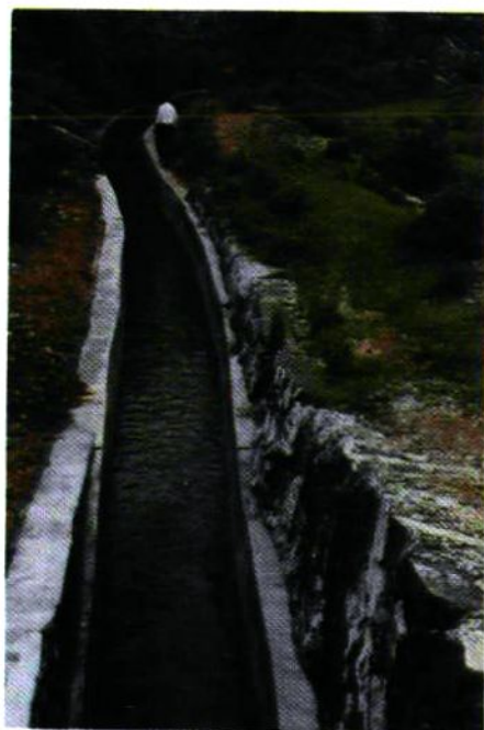
吕亭乡双龙水库干渠阻渗工程
