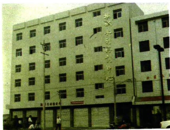
水利培训中心大楼
