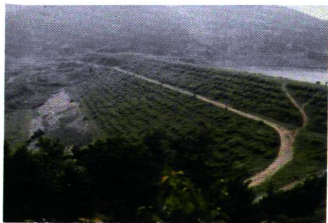
城关镇汪洋水库大坝掠影
