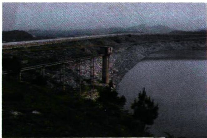
境主庙水库大坝内坡侧影
