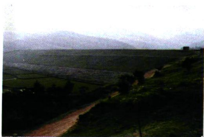
大关乡朱山冲水库大坝
