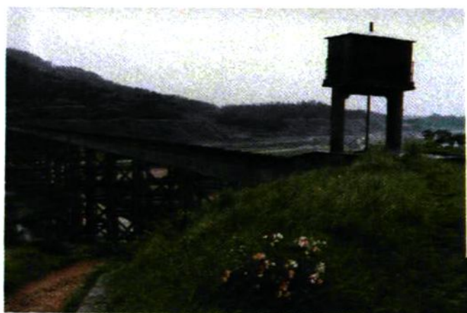
牯牛背水库东干渠首跨河渡槽
