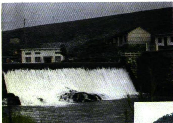
境主庙水库电站和总干渠首全景
