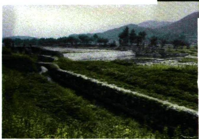
孔洪堰枢纽工程
