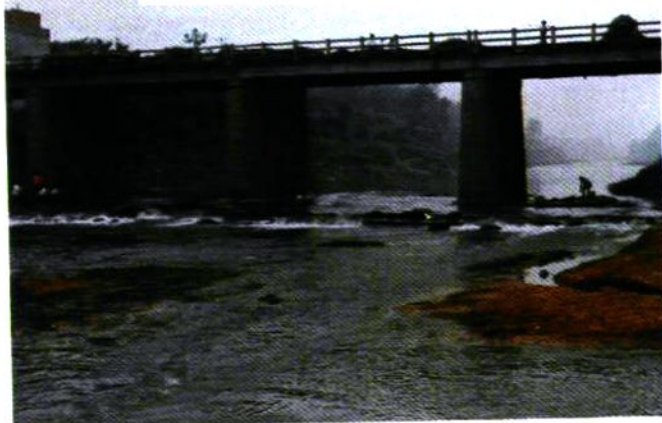
龙眼河出口切岭交叉工程——金神公路桥
