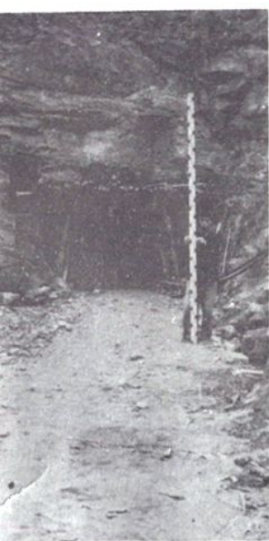
测量隧洞出水口
