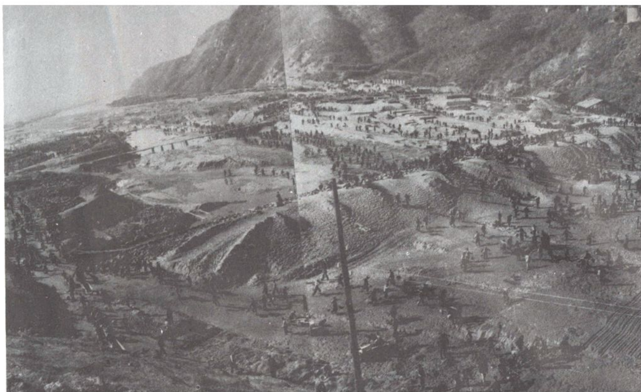
主坝施工全景
