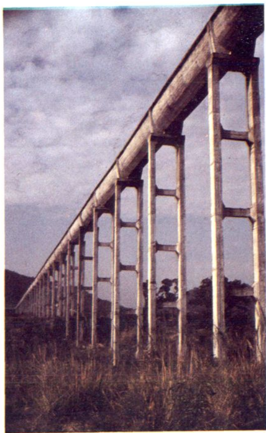
东干渠塄丘渡槽
