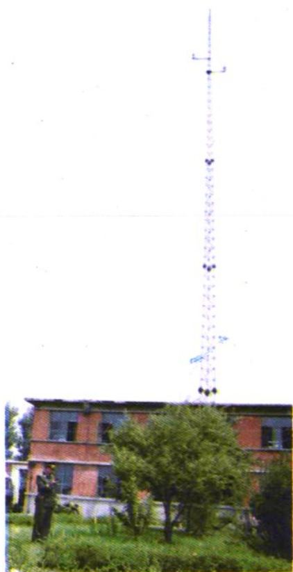
21 无线通讯基台
