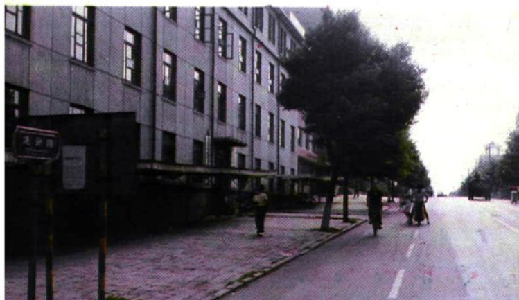
15 锦州工程公安段办公楼
