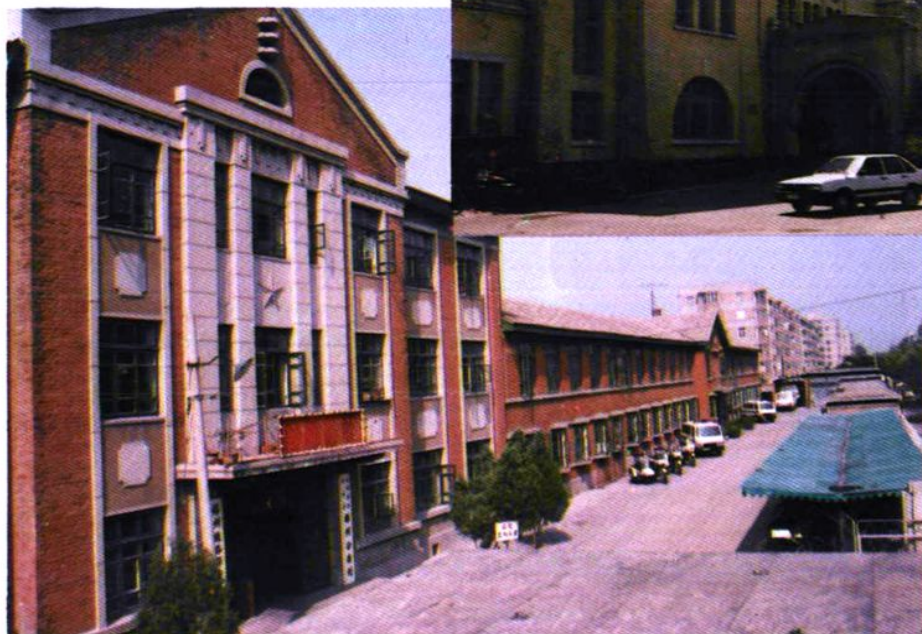
3 锦州公安处办公楼
