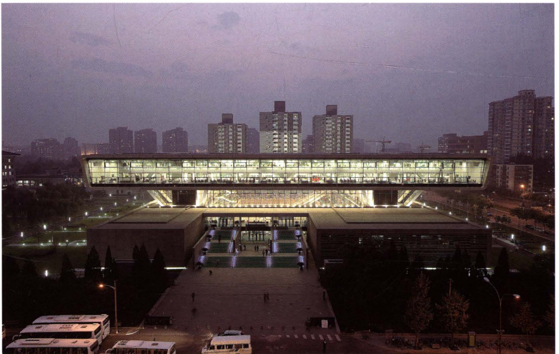
中关村南大街二期馆舍外景和正面
