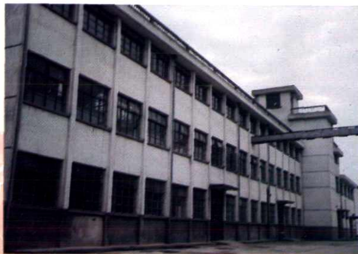
绍兴县第三粮油食品厂大米车间
