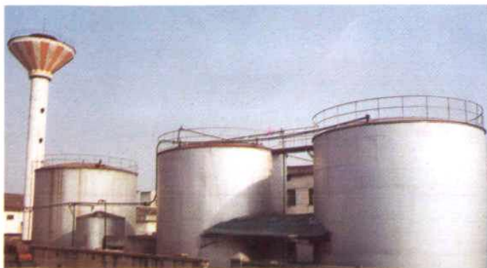
欣科粮油工业公司(柯桥)钢板储油罐
