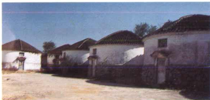
1972~1977年, 绍兴县先后建土圆仓40座, 总面积3122平方米, 总仓容544万千克。图为70年代马山粮管所吴融仓库的土圆仓
