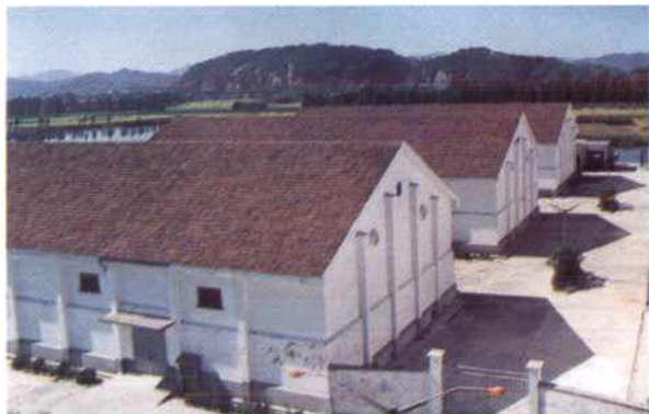
1972~1977年, 绍兴县先后建土圆仓40座, 总面积3122平方米, 总仓容544万千克。图为70年代马山粮管所吴融仓库的土圆仓
