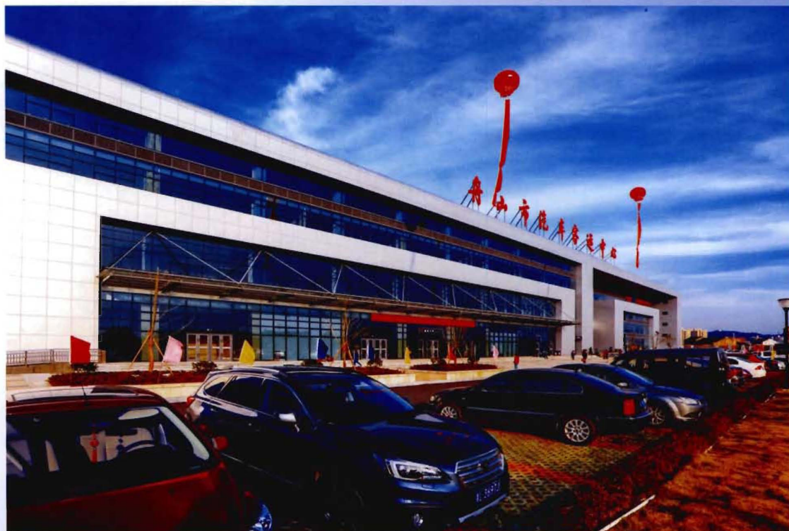
2015年11月27日,舟山市汽车客运中心(盐仓站)投入运行。
