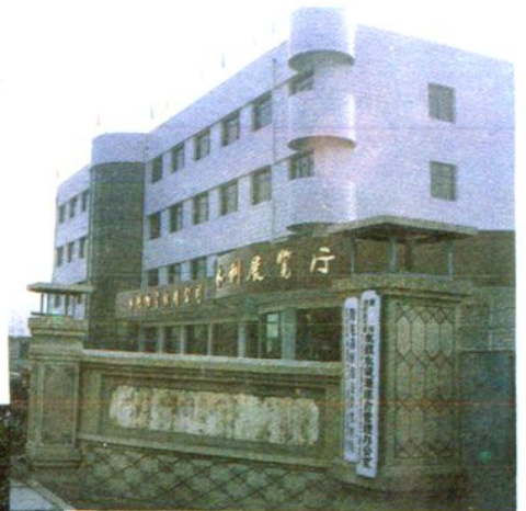
13. 水利局综合办公楼
